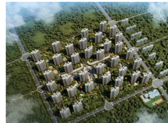
凤凰人家安置房建设工程项目
