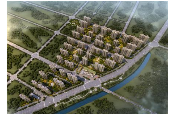
韩桥嘉苑安置房建设工程项目
